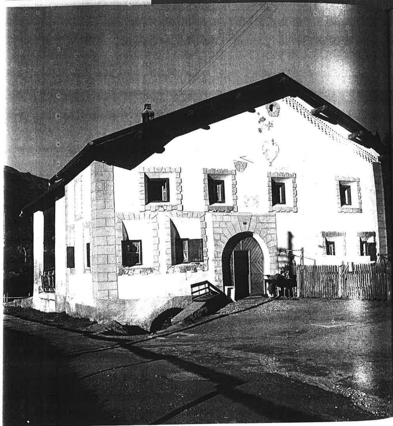
Die Vielweckbauten des Engadins vereinen einen Wirtschaftsteil mit eingetieftem Tor in die Chioff (Stall-, Kellergeschoss) und ebenerdig ein weiteres Tor in den Sulfer (Wohngeschoss, Scheune). Viele Häuser sind mit Sgraffito verziert. S-chanf GR
