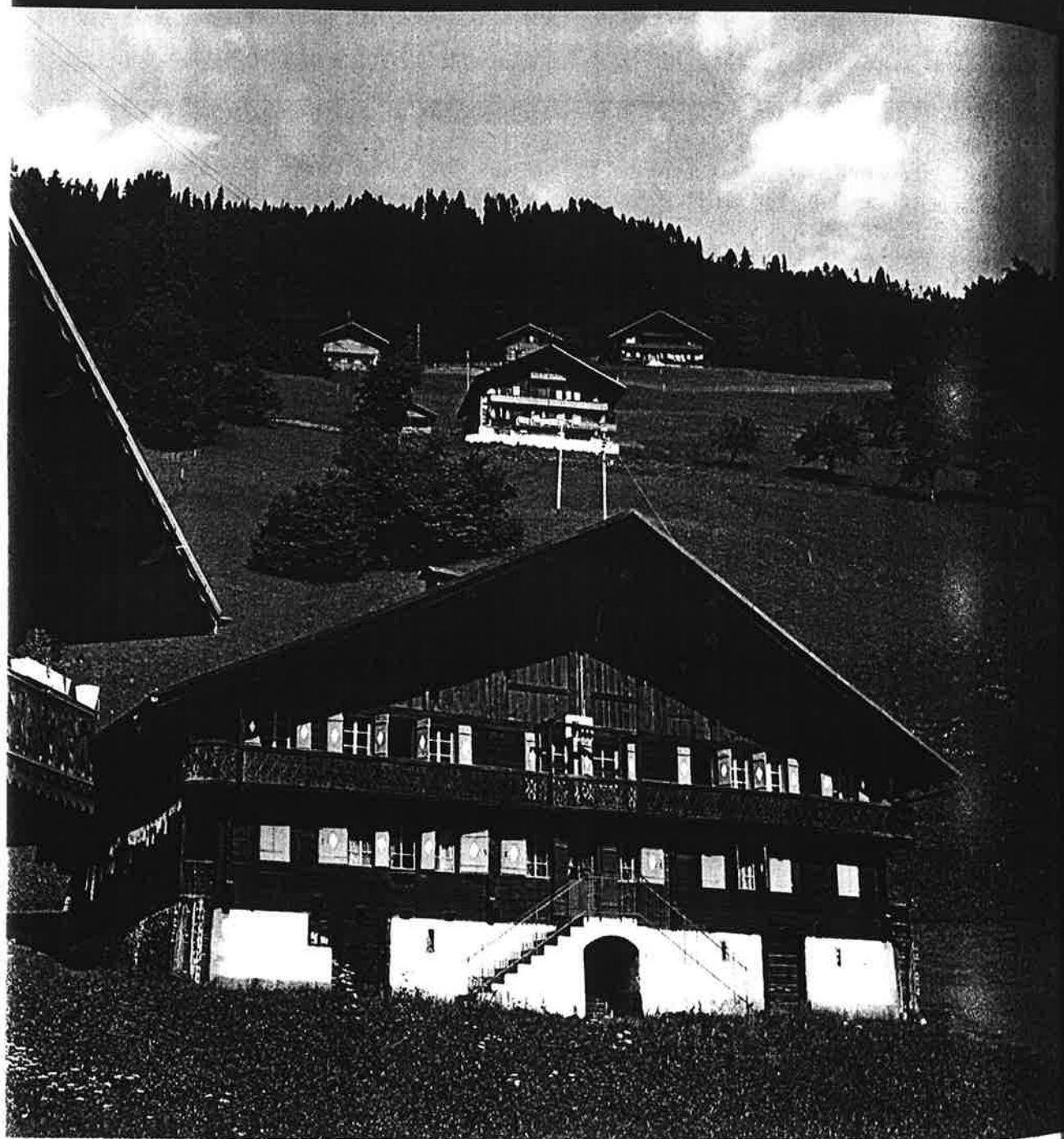
Die Häuser im Val d'Iliez haben auffällig stark vorgezogene Firste, so dass das Dach gegen die Traufe zurückweicht. Im satten Grün der Wiesen stehen nicht selten breite Doppelhäuser. Val d'Iliez VS
