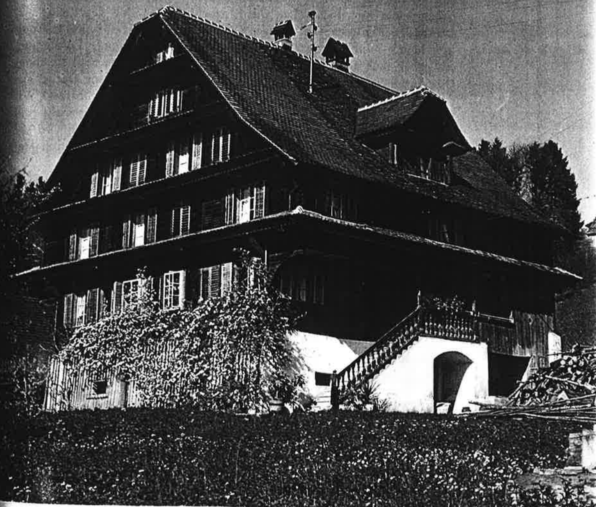
In manchen Teilen des Mittellandes haben die ursprünglich flachen «Tätschdachhäuser» repräsentativen, mehrstöckigen Bauten mit steilen Dächern Platz gemacht. Umlaufende Vor- oder Klebdächer gehören zum Bild. Meierskappel LU
